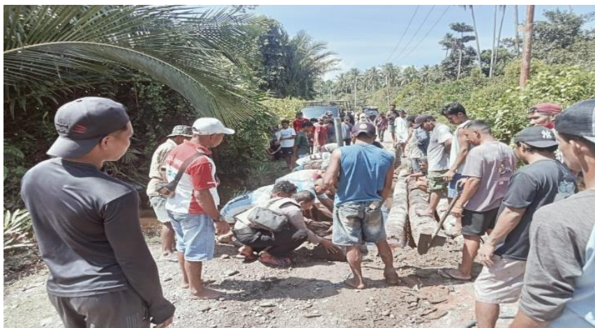
Dokumentasi 10. Gotong Royong Pembuatan Jembatan Darurat di Desa Ona
